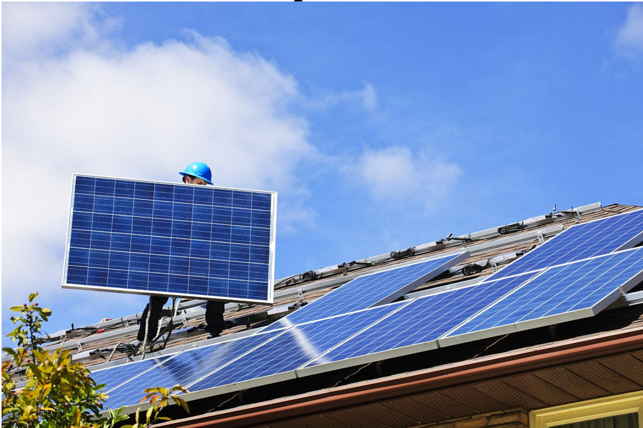
Installatie van zonnepanelen GettyImages
